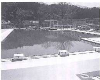
補助プール(右)も併設しています
