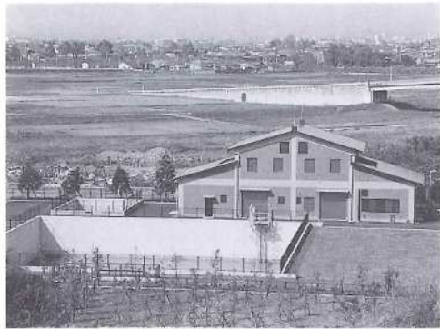
汚水処理施設
