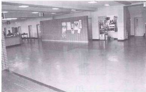
広くなった玄関ロビー
