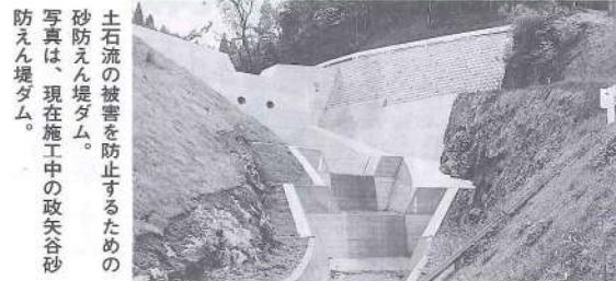
土石流の被害を防止するための砂防えん堤ダム。
