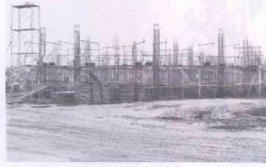
順調に進む三股西小校舎新築工事
