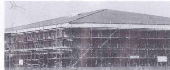
工事も順調に進む三股中体育館工事
