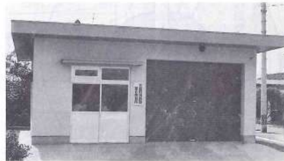
完成した消防詰所
