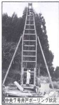
中央7号井戸ボーリング状況
