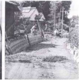
高畑寺柱線改良工事
