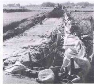
蓼池小園線舗装工事
