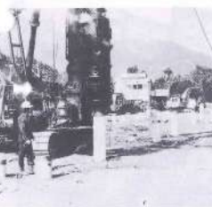
杭打工事風景
