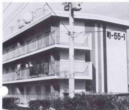
完成した山王原住宅
