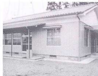
◀国民年金積立金還元融資により建設された宮村児童館
