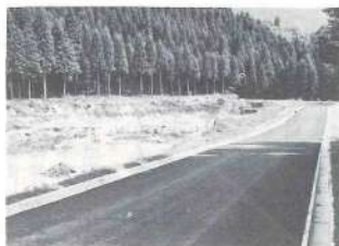
新設された処分地と搬入路
