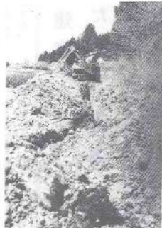
水道管敷設現場(田上)
