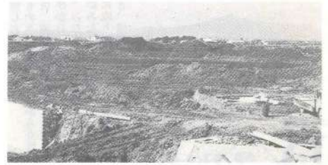
河辺田地区ほ場整備現場
