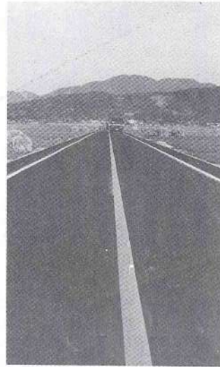
五本松・上米線舗装完成
