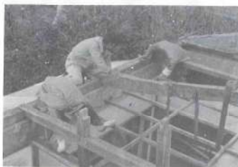
町営住宅の補修に精を出す奉仕隊
