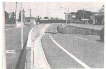
完成した立体交差
