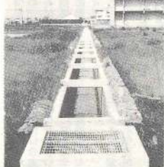
完成した下水道（五本松）
