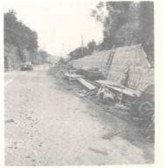
拡張工事現場・梶山
