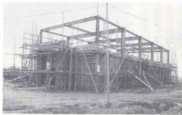
工事を急ぐ第2地区公民館
