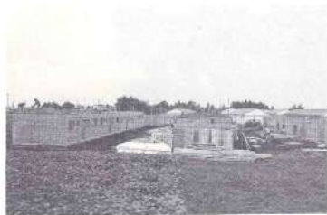
公営住宅建設現場・今市
