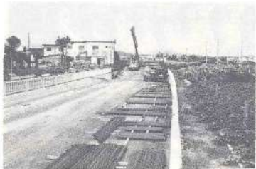
鉄道立体交差工事現場
