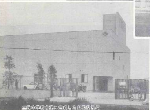
13 三陸中学校南側に完成した自動交換局
