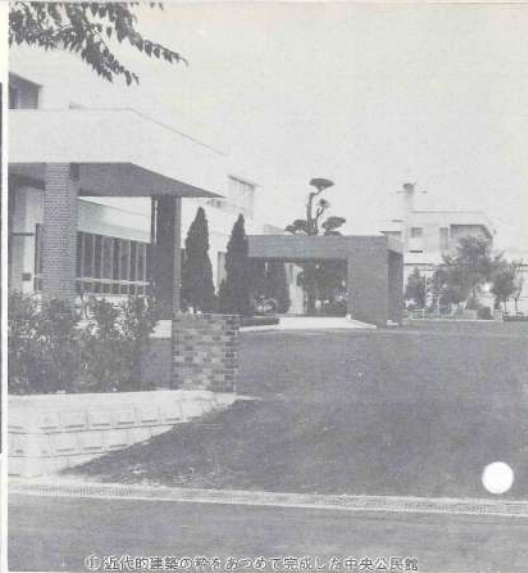
11 近代的生活の姿をかためて完成した中央公民館
