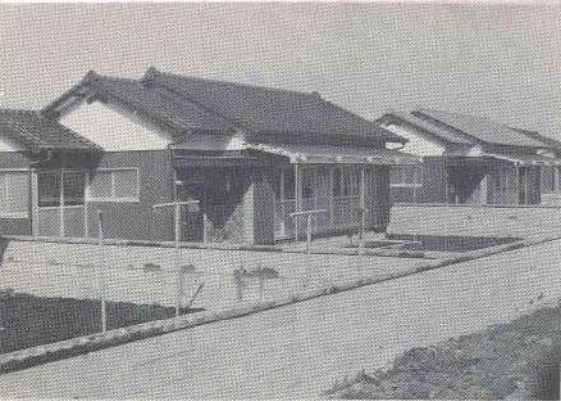
▲完成も間近い教職員住宅
