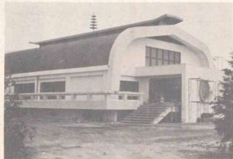
▼納骨堂は榊山、馨池、新馬場について第1地区、植木、田上も近く完成する。写真は第1地区納骨堂（建設費2,200万円）
