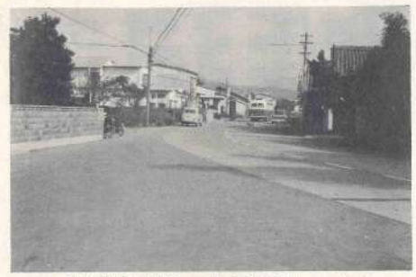
都三道路は、幅員11m、町内延長2,350m、これを町単事業として、昭和34年度より工費3,800万円と7年の才月を費して、昭和40年度に完成した。
