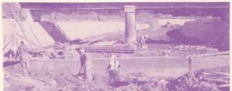
高畑川改修工事現場
