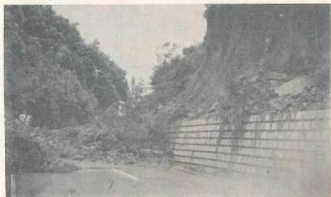
去る集中豪雨で、勝岡新坂決かい現場
