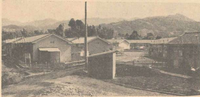
すばらしい簡保資金による町営住宅……塚原団地
