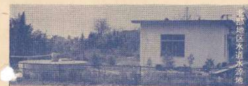
北部地区水道水源地
