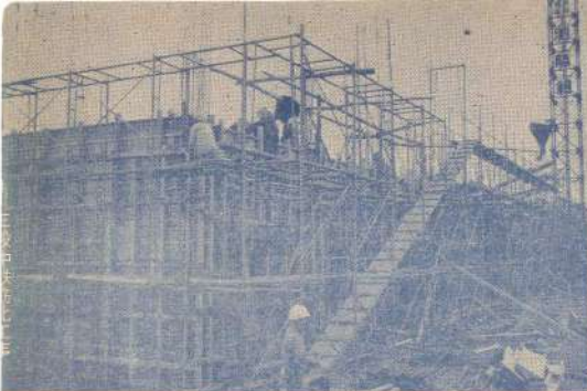
三股中校舎鉄筋化工事
