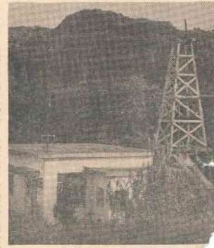
ボーリング現場
