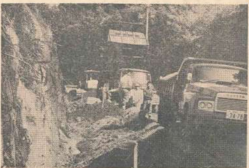
勝岡新坂改良工事現場
