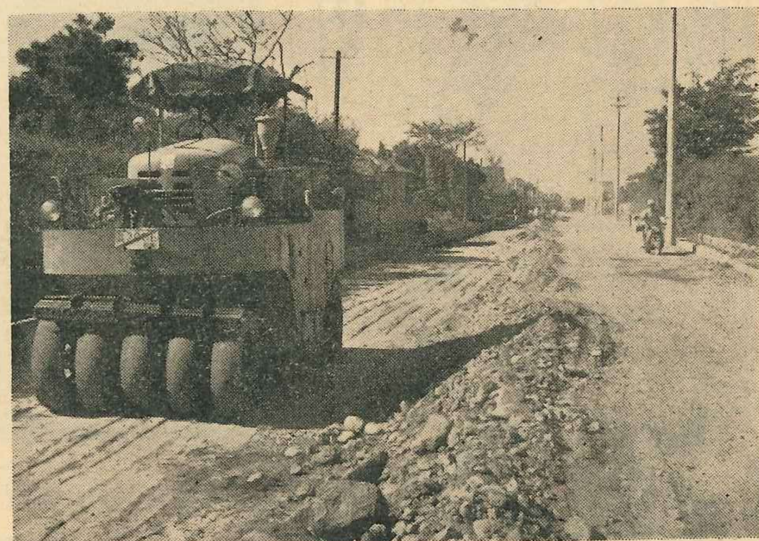
山王原(坂元線)舗装工事(県営) 今年度分約400米これで山王原地区は舗装完了
