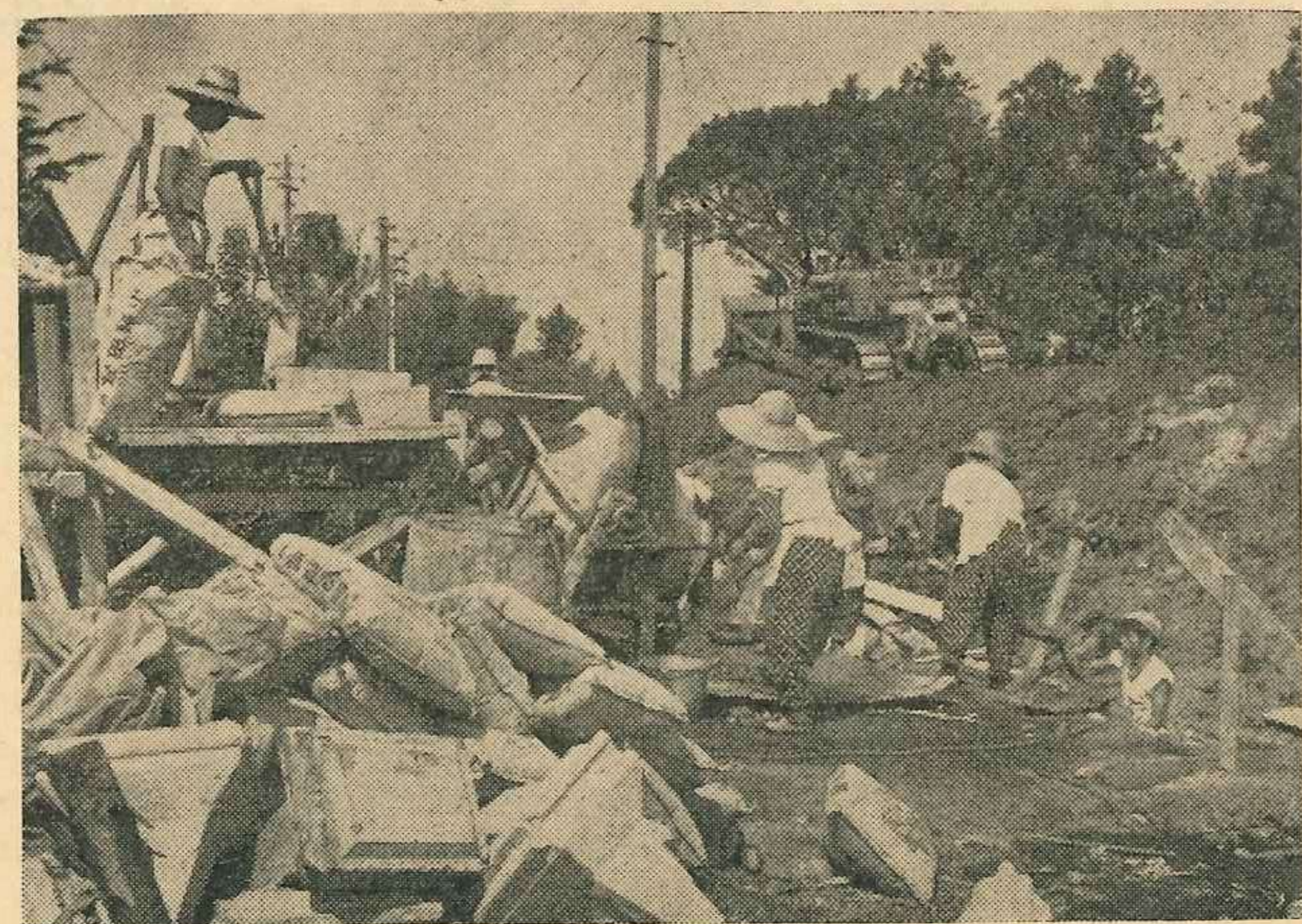
新馬場踏切立体化工事着々進行(県営)
