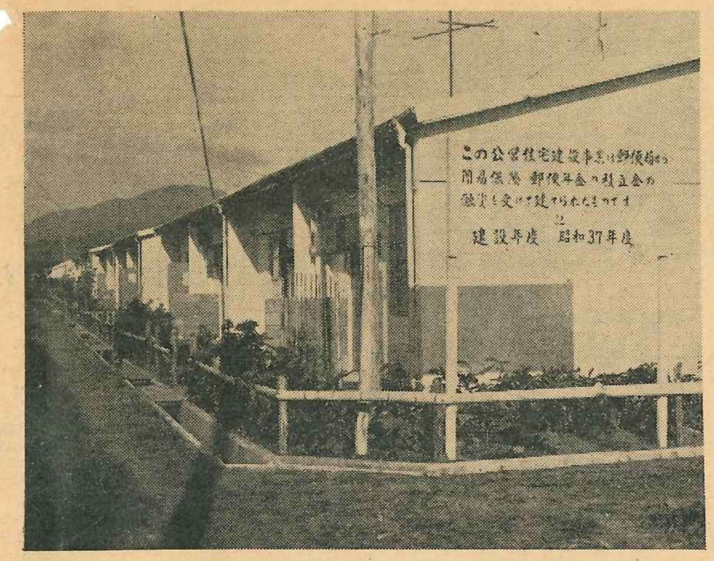
町営住宅 東原射場前団地 (35戸) 昭和37年度建設簡易耐火構造第2種 (9.5坪)
